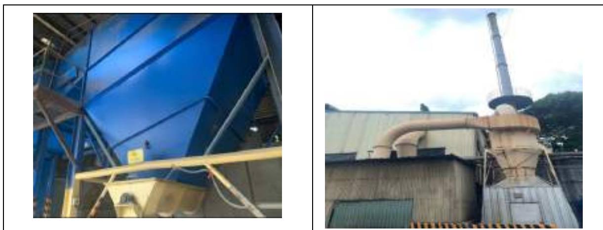
Hình 15: Hình ảnh HTXL khí thải lò hơi công suất 20.000 m 3 /giờ
