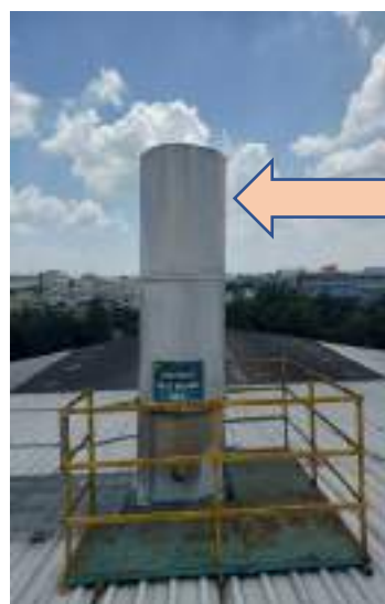
Ống lấy mẫu khí thải HT6 Kích thước phi 1100mm
