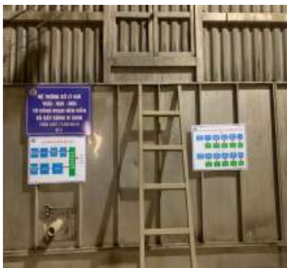
Hình 13: Một số hình ảnh hệ thống thu gom, xử lý bụi mùi từ công đoạn nén viên, sấy công suất 77.000m 3 /giờ
